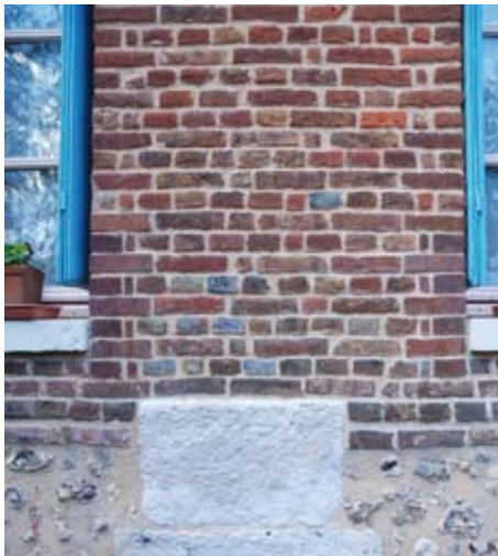
Briques, silix, craie, chaux : des matériaux locaux.
