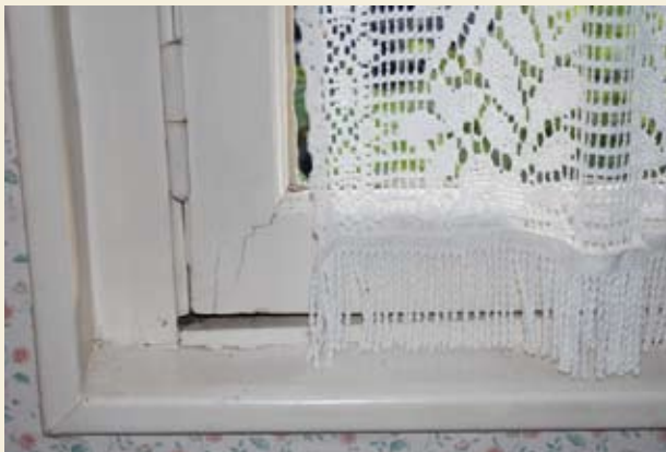
Fenêtre non jointive : les vieilles maisons ont la réputation d'être des « palais des courants d'air ».
