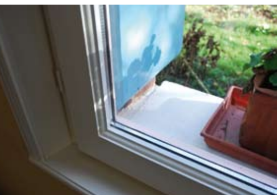
Double vitrage sur châssis bois.
