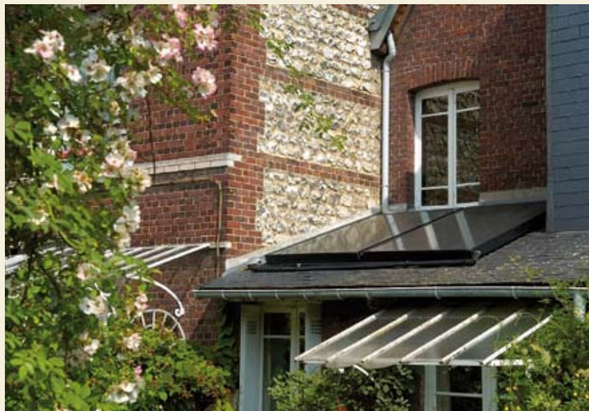
Panneau solaire : pas d'incompatibilité avec l'habitat ancien.
