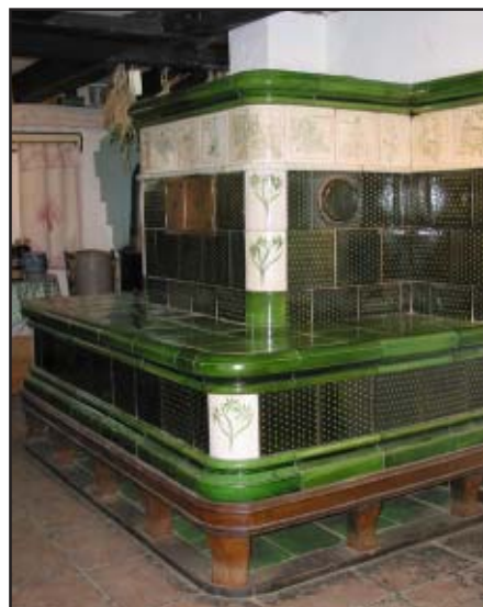
Les « poêles de masse » accumulent la chaleur et la restituent par rayonnement.
