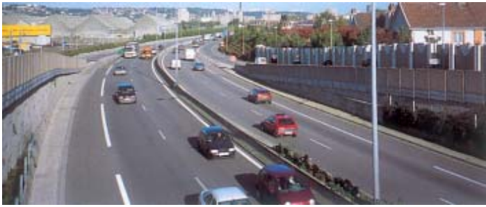
Le mur anti-bruit réduit les nuisances sonores dues à la circulation automobile.
